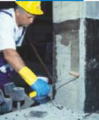
Applicazione di MapeWrap Primer 1
